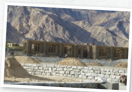
Construction de l'école bioclimatique au printemps 2014
