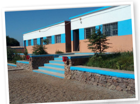
Aménagement extérieur de l'école
