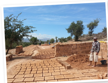
Fabrication des adobes (briques en terre crue)
