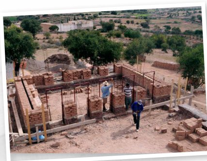
Mur en pierre constituant les soubassements des bâtiments
