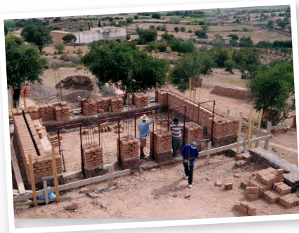
Vue d'ensemble du chantier
