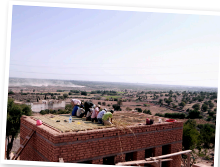
Pose du plafond en roseau
