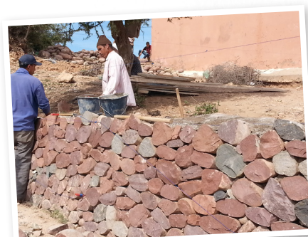
Construction du mur en pierre
