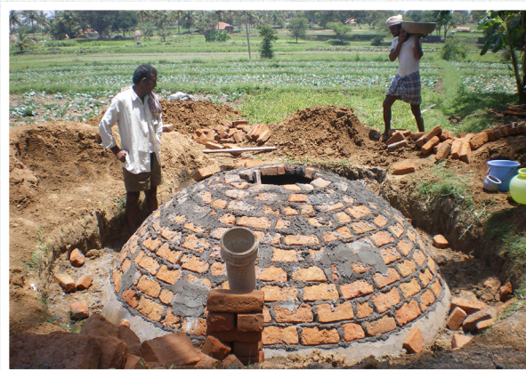
Construction d'un réservoir à biogaz, district d'Hassan
