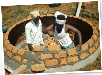
Construction d'un réservoir
