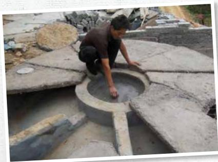
Construction du bio-digesteur
